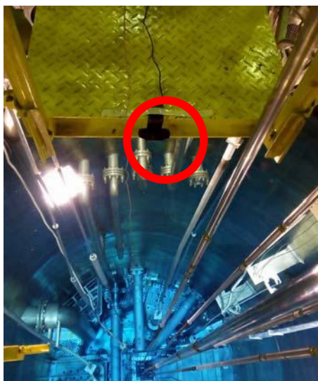
Figura 3. Instalación de la cámara de video en boca de tanque del reactor RP-10.
