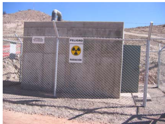
Figura 3. Vista lateral de almacén de fuentes radiactivas.
