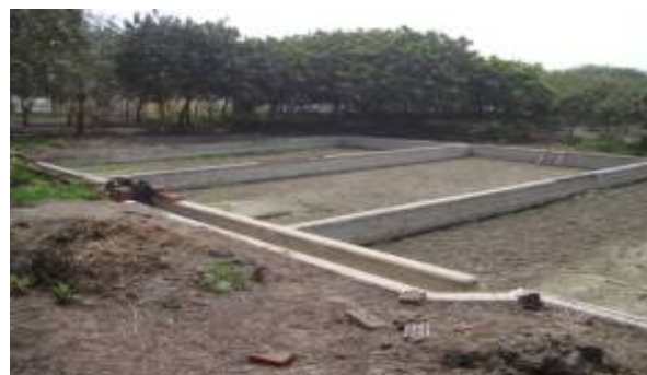
Figura 3. Lodos en la Piscinas de Lecho Filtrado.
