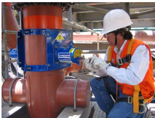
Figura 1. Operación de mantenimiento preventivo.
