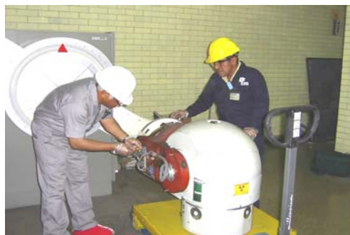
Figura 3. Retiro de chasis externo de cabezal y brazo de Gantry.
