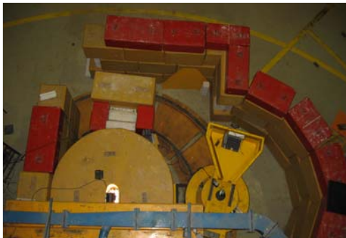
Figura 3. Blindaje radiológico de primer eje y blindaje externo.
