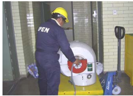
Figura 6. Fijación de placas laterales para soldar el cabezal.
