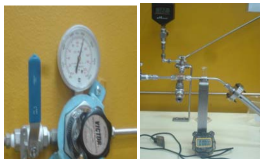
Figura 8. Manómetro de salida de gas de helio y Ramal 1 para ensayo de presión externa.
