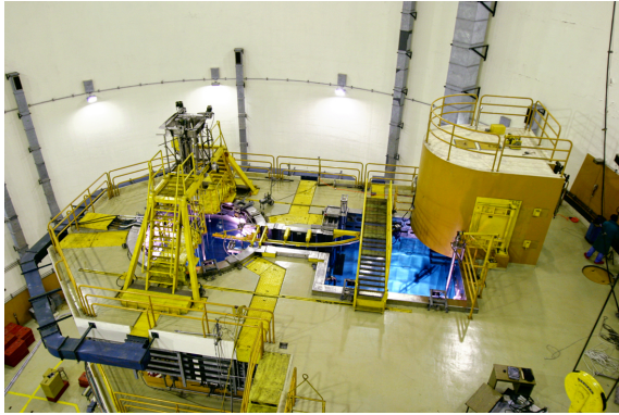
Figura 8.1: La parte superior del reactor RP-10. Se observa la piscina circular en cuyo fondo está el núcleo del reactor, y las barras de control que bajan manejadas desde la sala de control del reactor. Foto IPEN.
