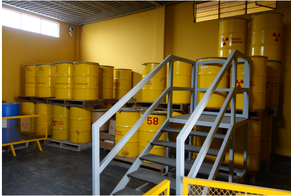
Figura 6.4: El Instituto Peruano de Energía Nuclear cuenta con una planta de gestión de residuos radiactivos (PGRR), donde deben ir las fuentes radiactivas que han cumplido su tiempo de uso. Foto IPEN.
